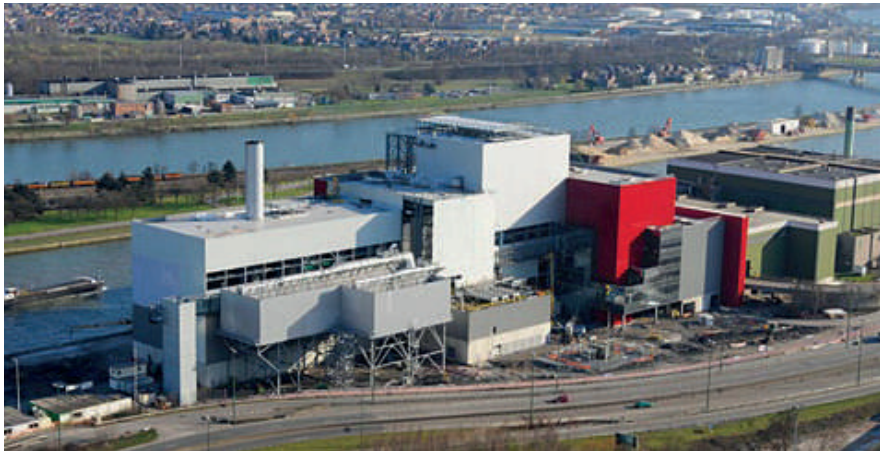
Centre de valorisation énergétique UVELIA - INTRADEL
